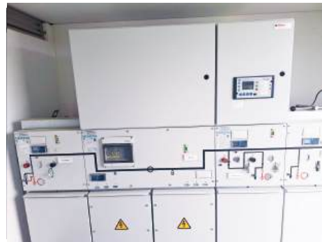
Mittelspannungs-Anlage Jossi
