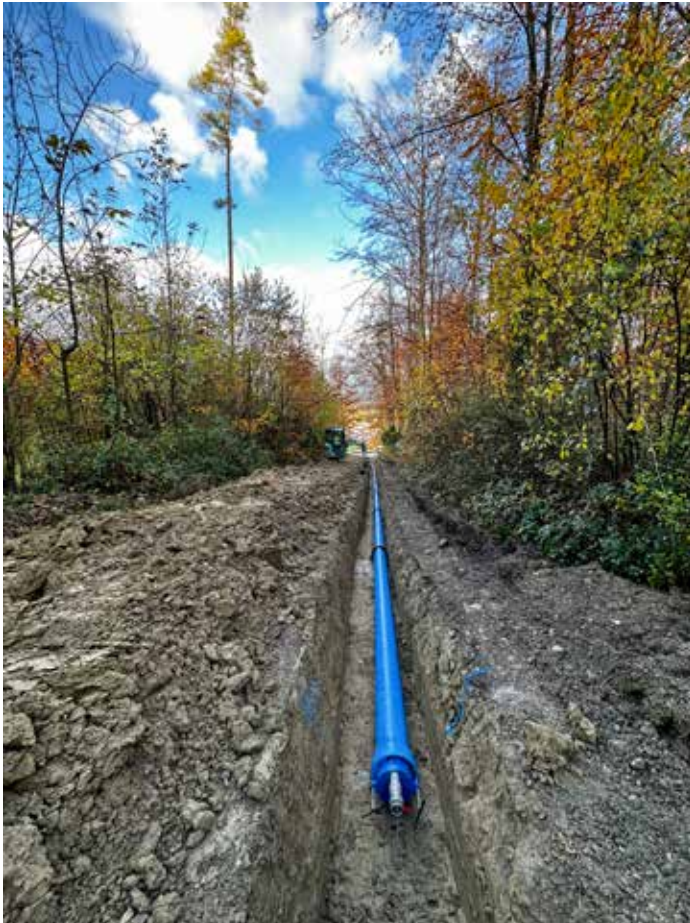
Sanierung Wasserleitung Forre
