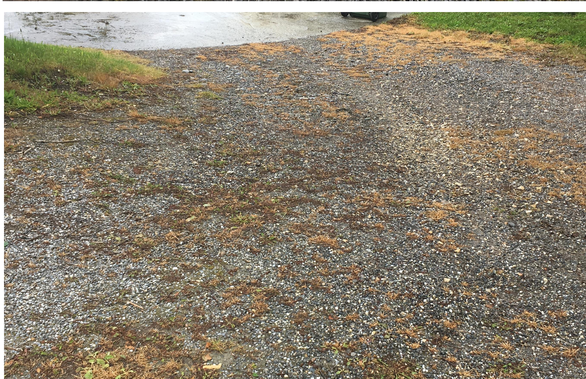
Herbizide können durch den Kies ins Grundwasser sickern.
